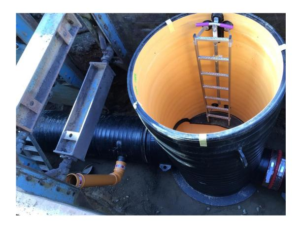
Alle Schmutzwasser- und Regenwasserhausanschlüsse im vorgenannten Ausbaubereich wurden mit Rohren Durchmesser DN 160 aus PP erneuert und an die neuen Kanalhaltungen angeschlossen.
